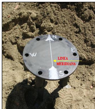
Fig. 24. Si prepara la flangia di metallo che sosterrà l' Armilla Equatoriale , tracciandovi sopra la Linea Meridiana . Questa operazione permetterà successivamente di collocare la flangia nella giusta direzione Nord-Sud.
