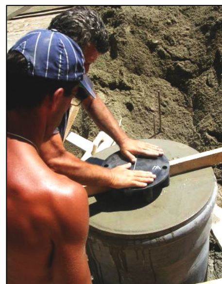
Fig. 25. Si inserisce la flangia in una gettata fresca di cemento armato, collocandola orizzontalmente e orientandola lungo la direttrice della Linea Meridiana praticata in precedenza sul terreno.
