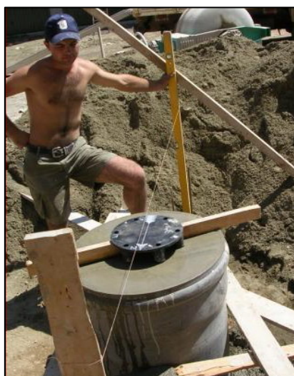
Fig. 25. Si collima, con una corda tesa, la direttrice delle due aste piantate sul terreno con la Linea Meridiana della flangia.
