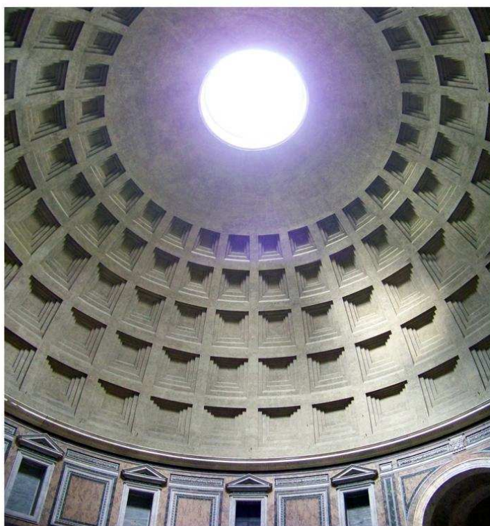
La cupola del Pantheon con l'oculo centrale di nove metri di diametro e le cinque file di cassettoni, di dimensioni decrescenti. Ogni fila ne aveva ventotto (foto M.D.F.)
