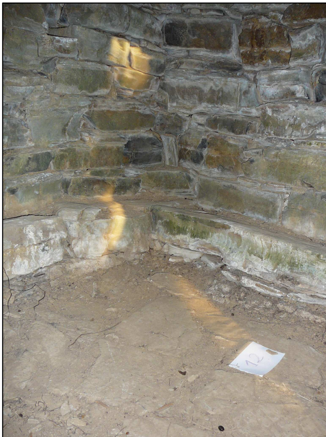
Figura 11. Cavaneo del Debbio. Gli ultimi raggi equinoziali entrano diagonalmente nella struttura del cavaneo.
