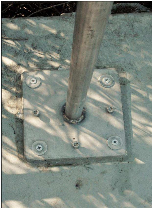
Fig. 15. Base asta verticale con viti di fissaggio.
