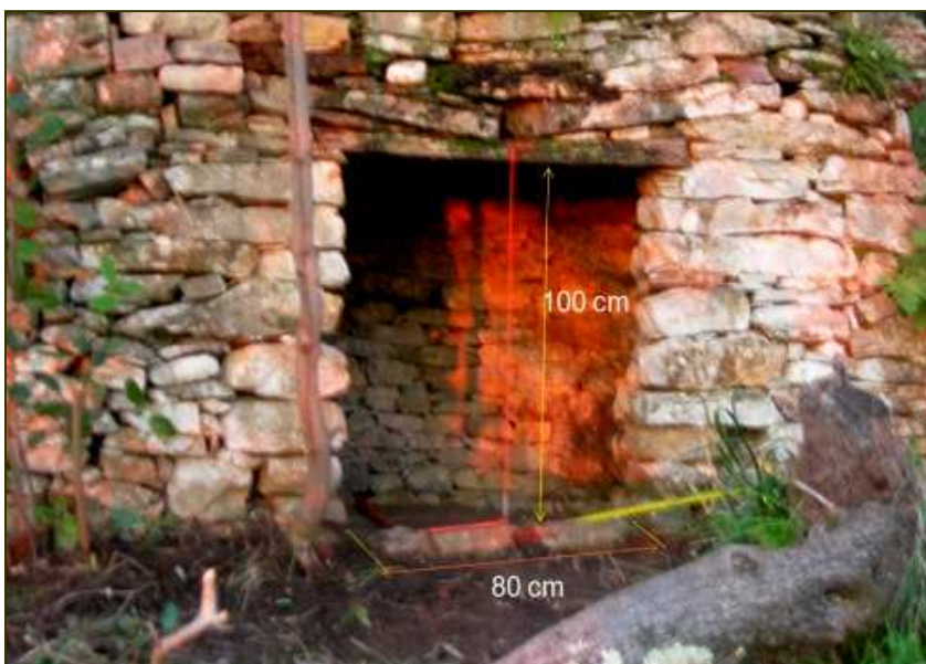
Figura 2. Dimensioni della porta d'ingresso.
