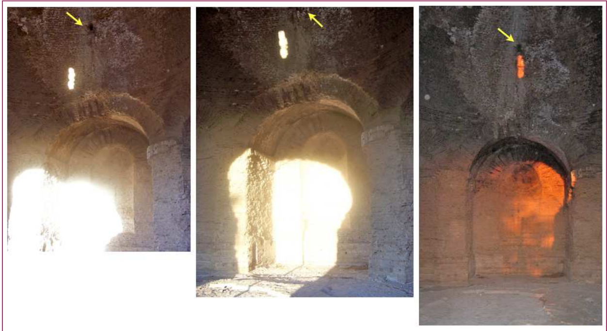
Fig.12 – 19 giugno 2009. Roccabruna. Al tramonto del Sole, la lama di luce creata dal condotto B si muove all'interno della cupola con un percorso ad arco fino a sfiorare la feritoia (indicata dalla freccia) in cui sbucano i condotti D-E. (foto di Marina De Franceschini)
